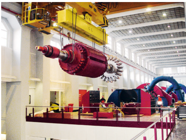
Montage eines Rotors in einem Kraftwerk
