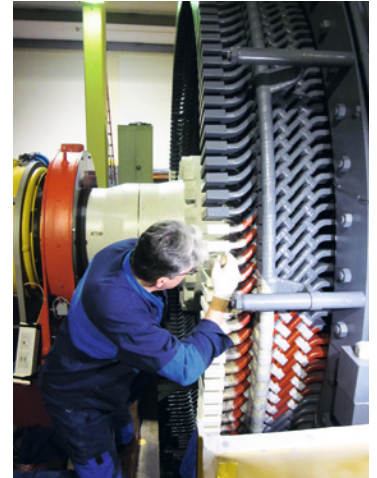
Blick auf Revisionsarbeiten in einem Kraftwerk
