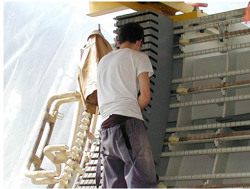
Neublechungsarbeiten an einem 120 MVA Stator
